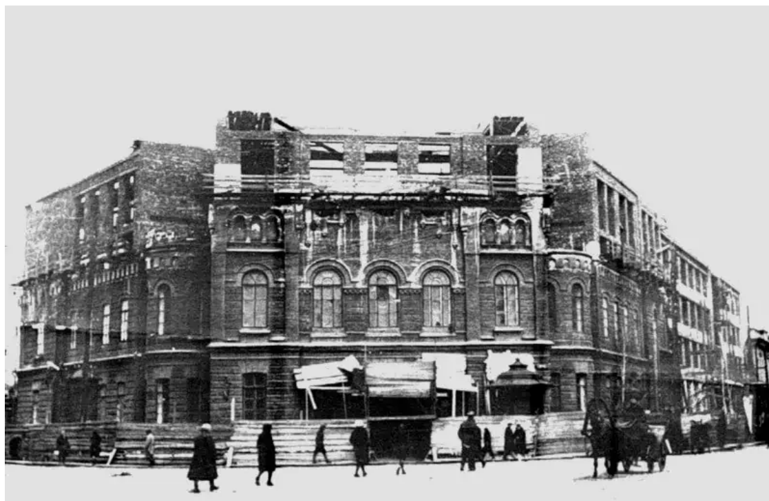
Рис. 6. Строительство здания СФЭИ, начало 1930-х гг.
